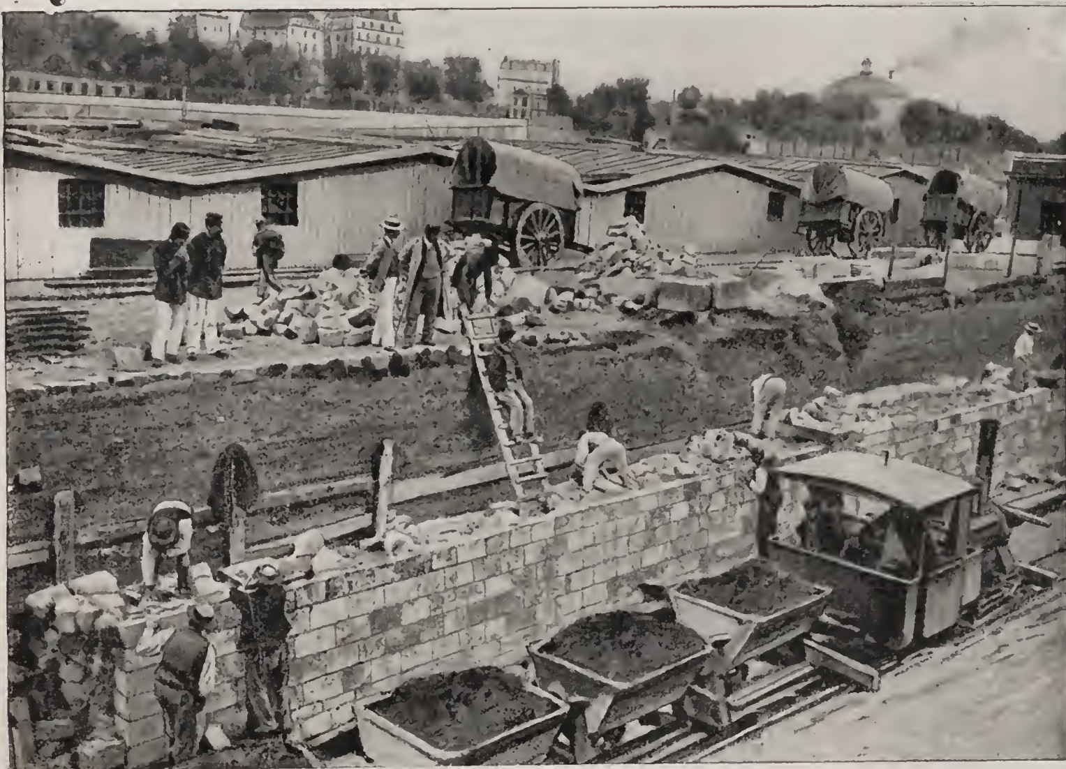
LE PROLONGEMENT DES LIGNES DE LA C ie D'ORLÉANS. — Construction du mur de tranchée, au quai Saint-Bernard.
